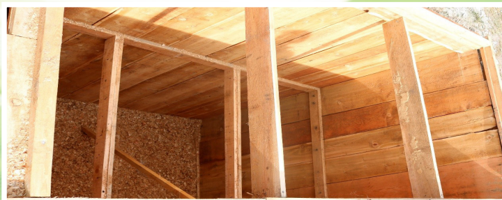
Урт 3 м, өндөр 3 м, өргөн 1,5 м хэмжээтэй, доторлогоотой нүхний ёроолд 50 см зузаантай үртэс дэвссэн байдал
